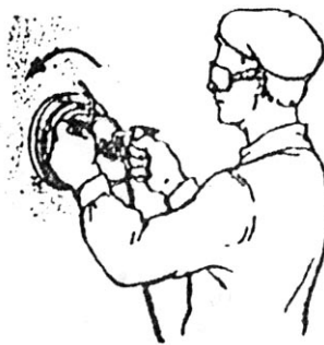
ნახ. 13.9. მობათქაშებული ზედაპირის წაგლესვა საგლესი მანქანით
